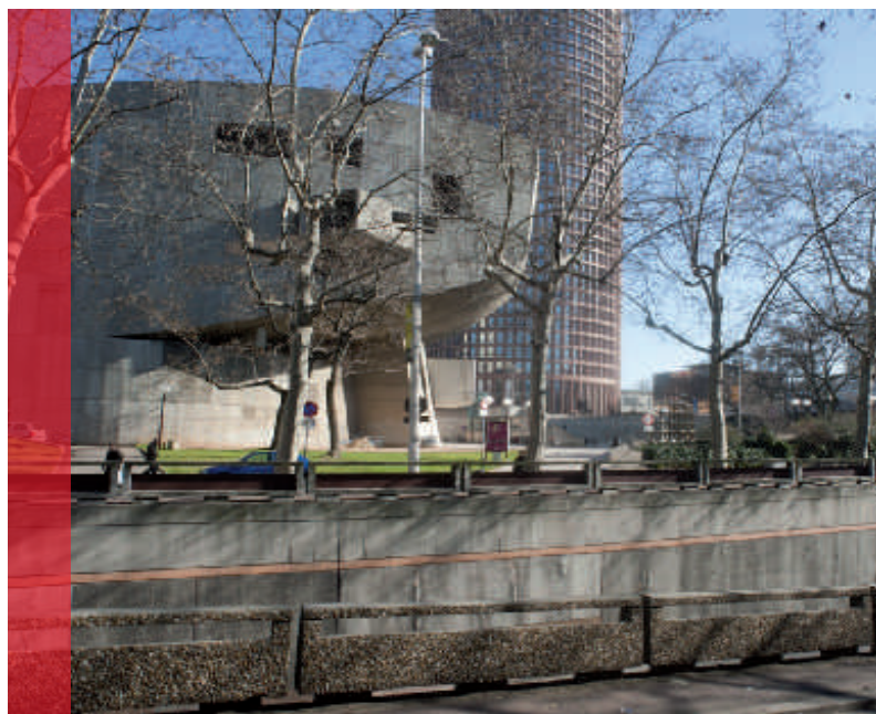
L'Auditorium, peu visible et dont l'accès est difficile depuis la rue Garibaldi.
